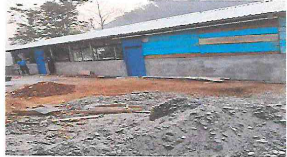
Foto 2: aquí se observa que los consejos se queda bajo la responsabilidad de cuidar el edificio escolar
