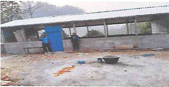
Foto1: se observa que el edificio escolar se ha finalizado en la reparación
